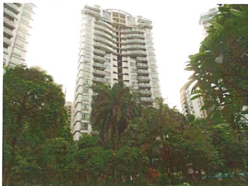
估价对象楼栋外观
