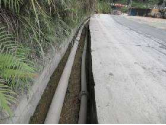
道路一侧排水沟 (2017.10.18)
