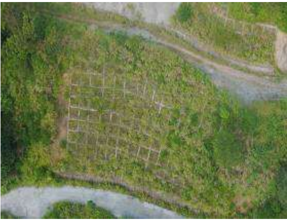
道路边坡防护 (2017.10.18)
