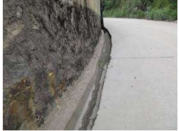
挡墙及排水沟 (2017.10.18)
