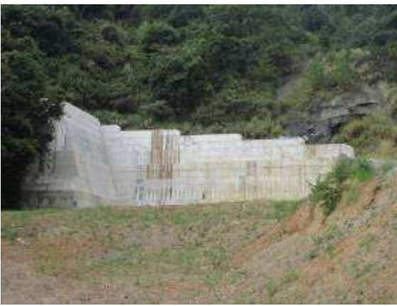
540 废石场及挡墙 (2017.10.18)
