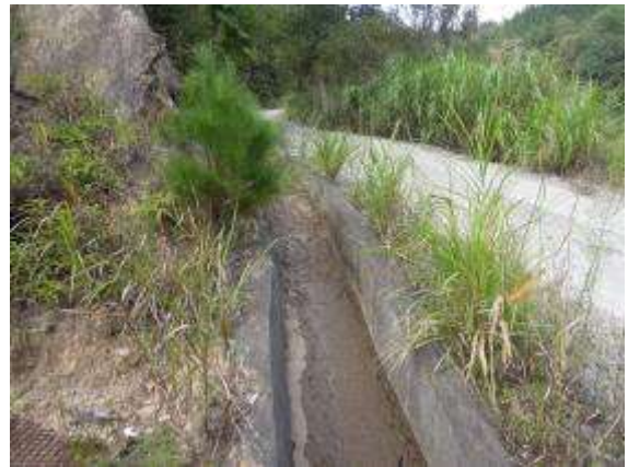
道路一侧排水沟 (2017.10.18)
