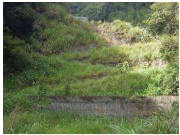
540 废石场及挡墙 (2017.10.18)
