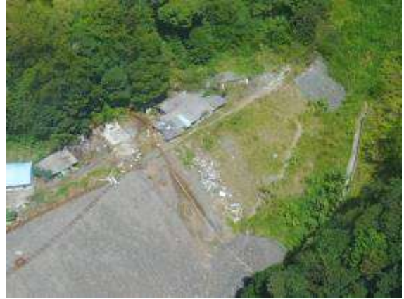
490 废石场复绿及排水沟 (2017.10.18)
