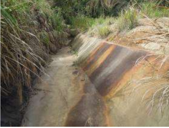
2#尾矿库排洪沟 (2017.10.18)
