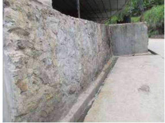
采矿场地排水沟 (2017.10.18)
