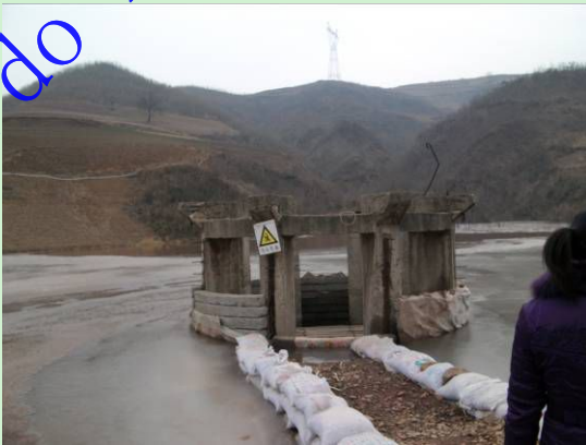
尾矿库内排水井
