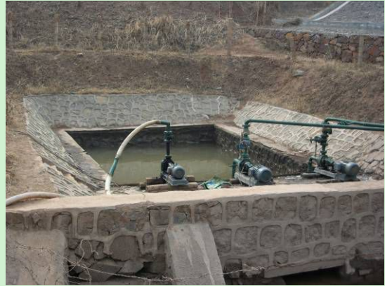
尾矿库坝底事故池
